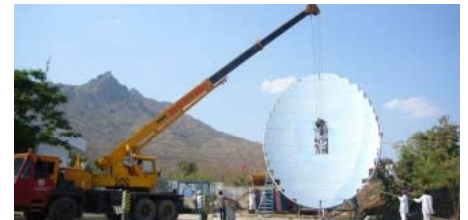
Em Shantivan, um campus para 20.000 pessoas, a BK está construindo instalação de energia solar para abastecimento de toda a energia necessária.
